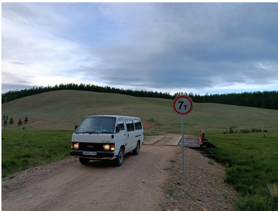
Монды-Ханх горные дороги общего пользования 33 км
